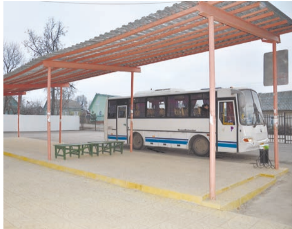
Отремонтирована территория автостанции в г.Медынь
